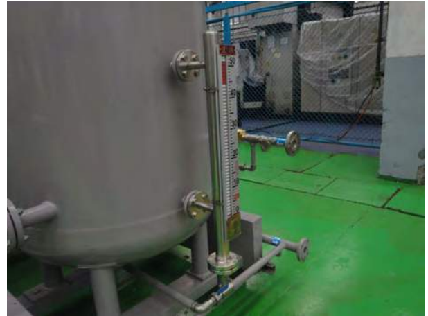
磁翻板液位计：现场显示清晰，远传液位报警
