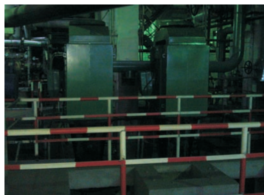
新疆天龙矿业有限公司2×200MW
