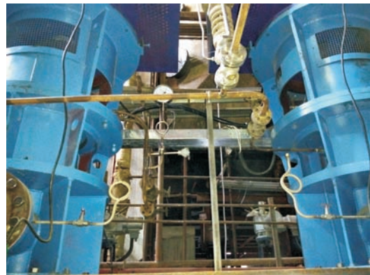
印尼青山不锈钢有限公司2×350MW
